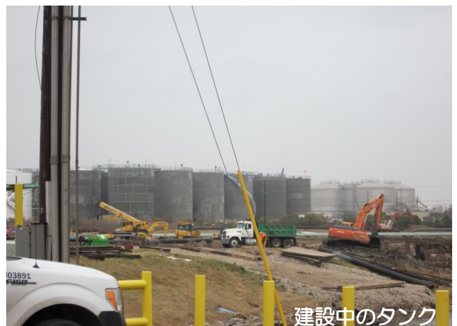
オイルタンキング 原油タンクとパイプライン
